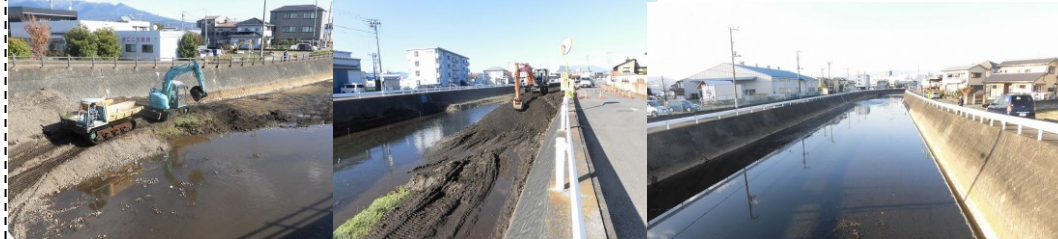
小潤井川の浚渫工事が完了(1/初旬)・河川改修整備に伴い、草刈りしてきた区間もきれいに浚渫されました！！
